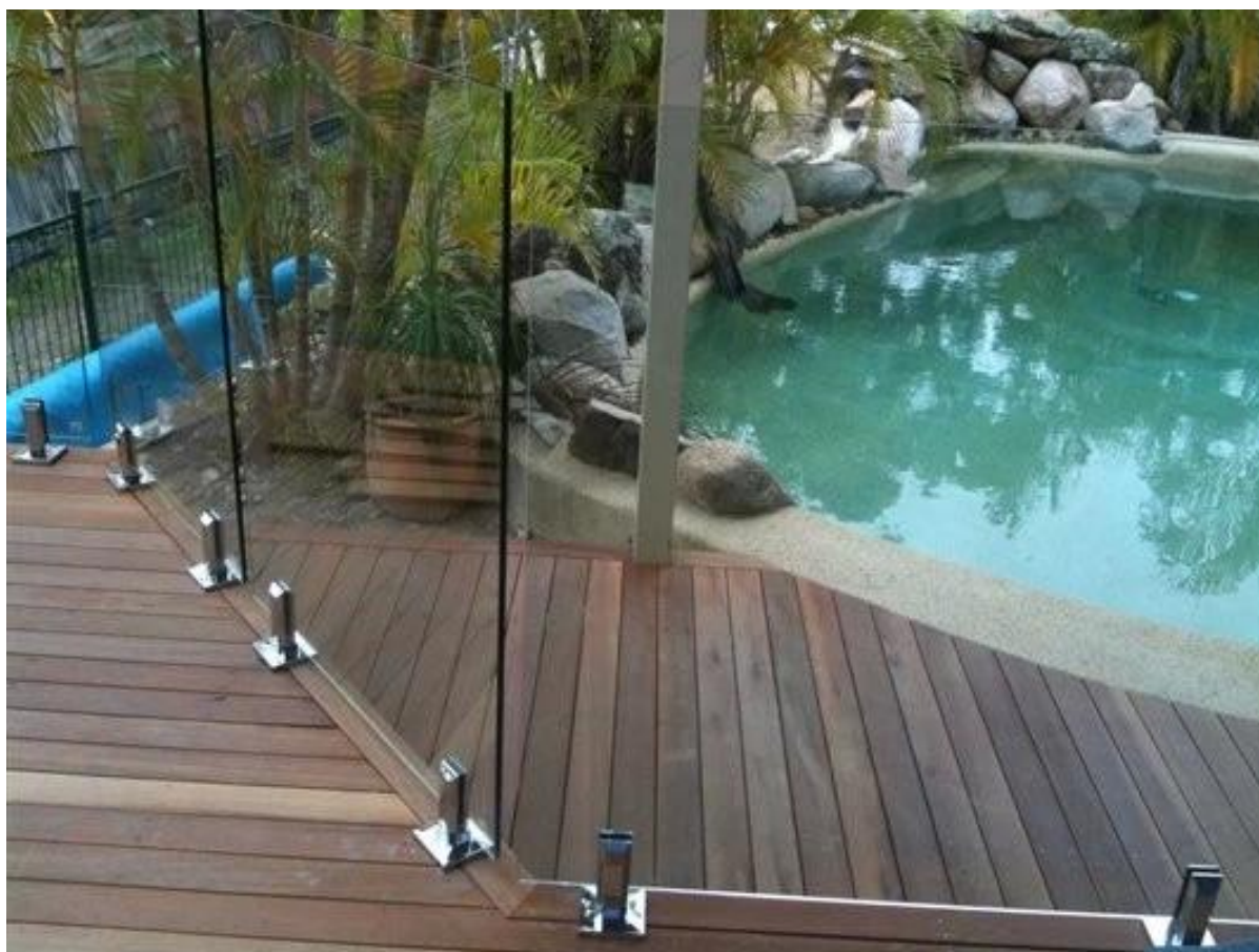
ruostumatonta terästä 316 tapin, kehyksetön lasi miekkailu tapin, neliö pohjalevy spigot
