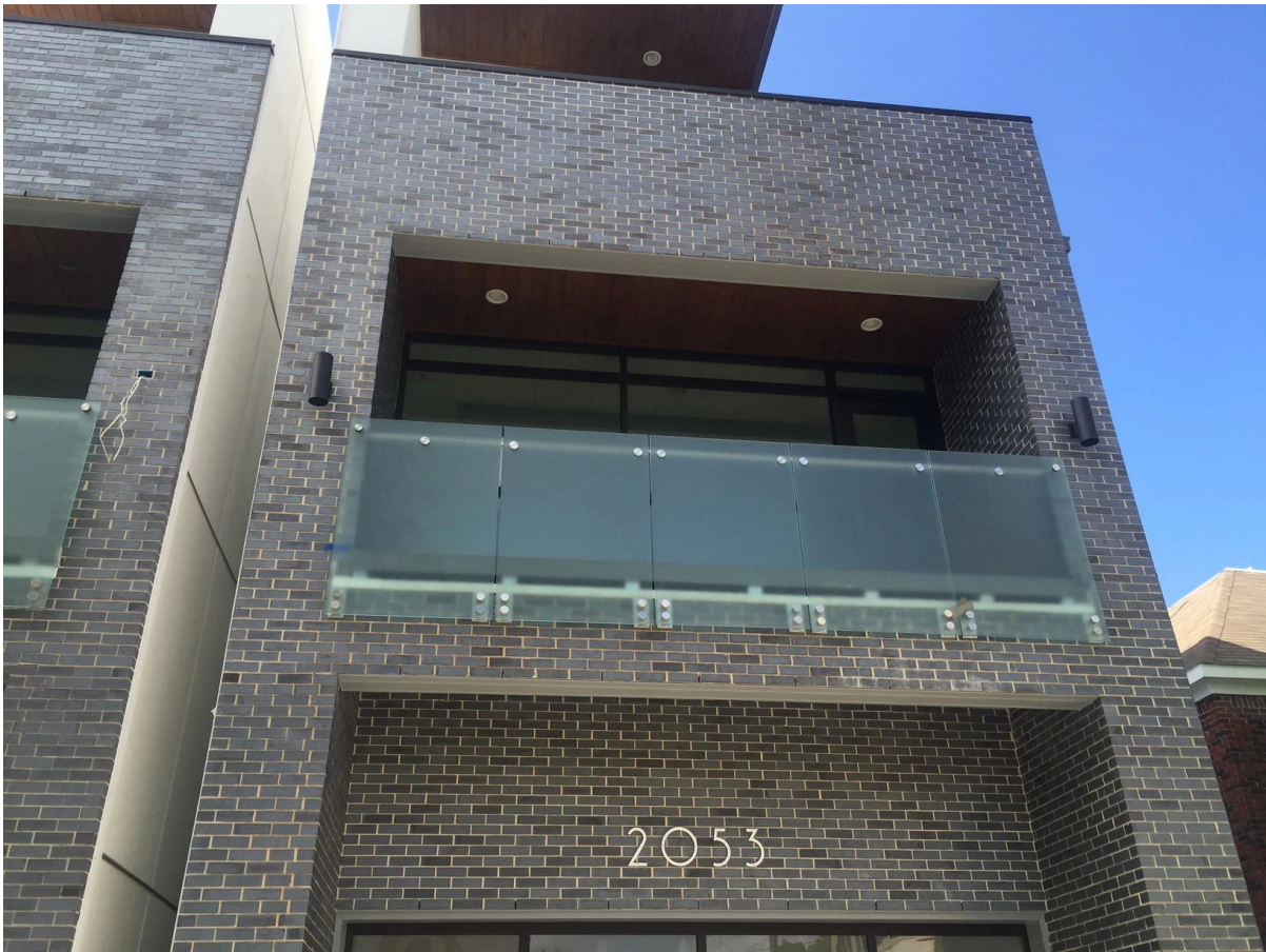
Asennus kuvia lasikaide standoff kiinnike
