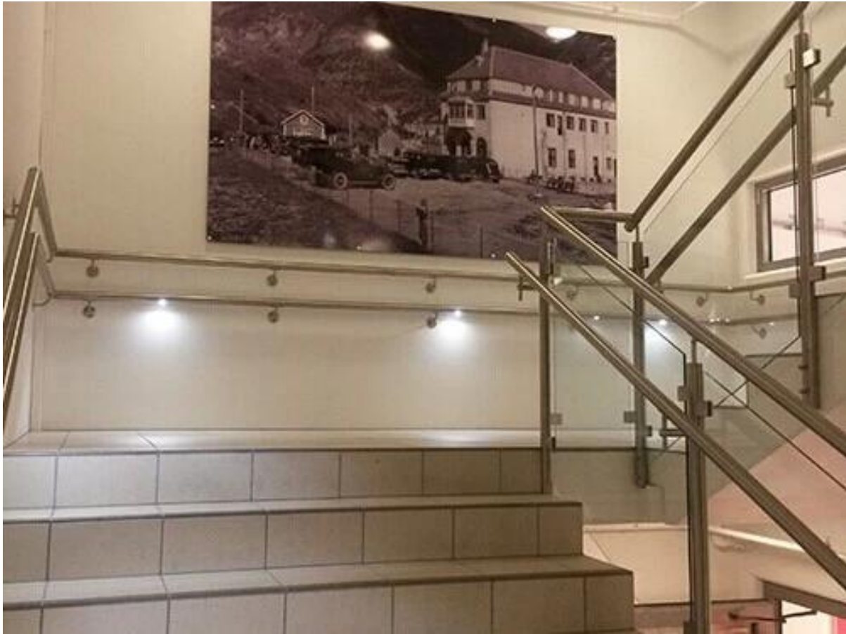
pyöreä putki liitin käyttää ruostumatonta terästä portaikon kaide
