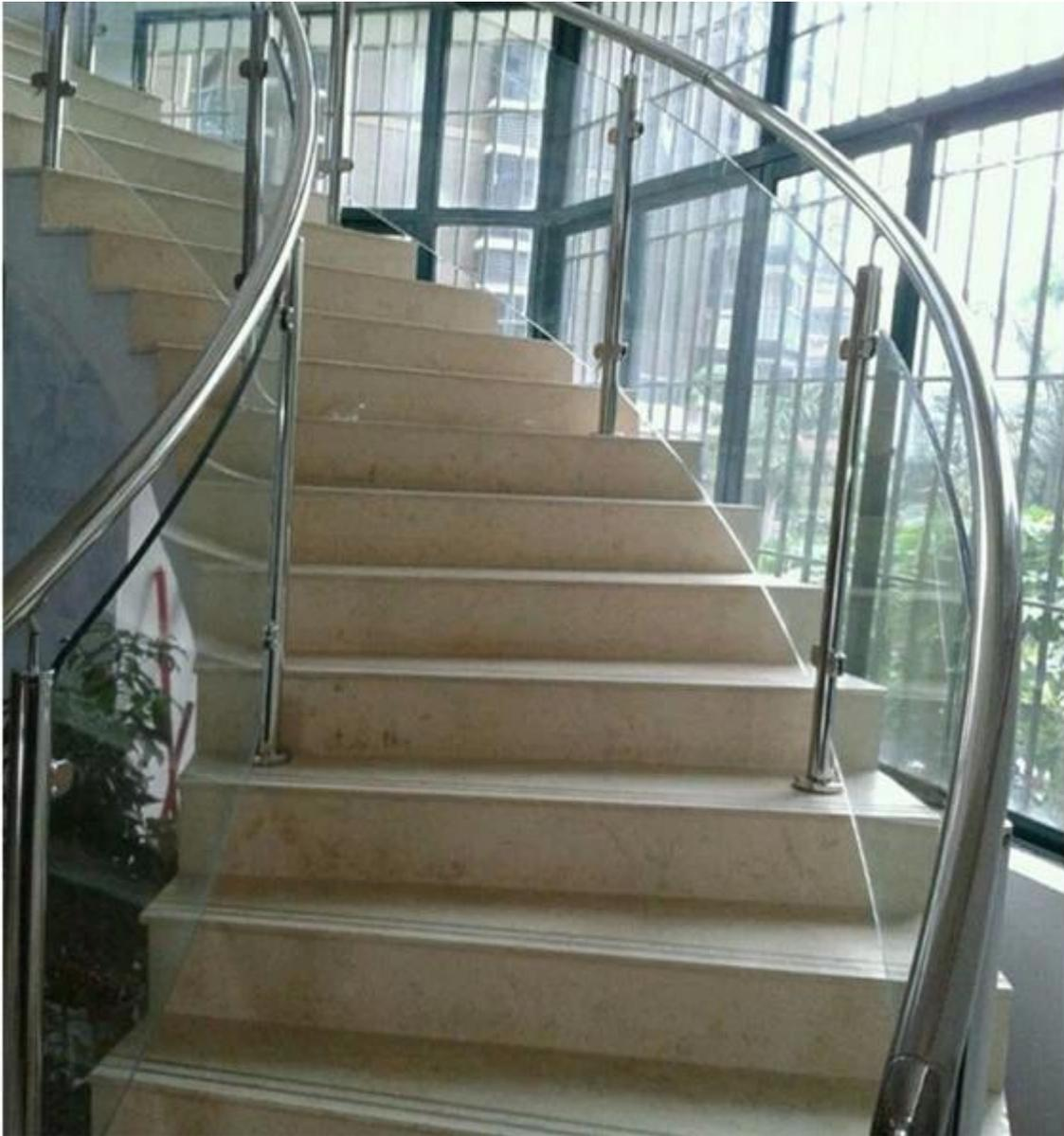
poteau intermédiaire 2 voies de 180 degrés et le poteau de coin de 90 degrés
