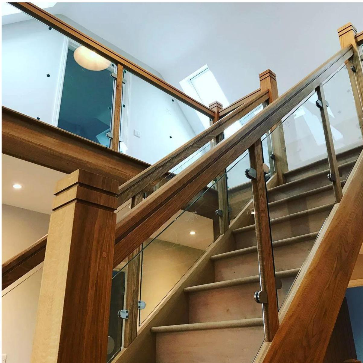
la pince est généralement utilisée avec une tige en acier inoxydable pour maintenir les panneaux de verre, pour la balustrade de balcon, la balustrade de terrasse, l'escalier. Convient pour les portes intérieures et extérieures.
