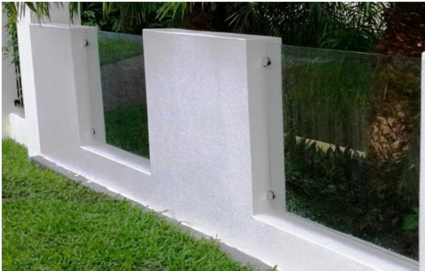
La pince pour garde-corps en verre est généralement utilisée avec un poteau en acier inoxydable pour maintenir les panneaux de verre, pour garde-corps de balcon, garde-corps de terrasse, escalier. Convient pour l'intérieur et l'extérieur.
