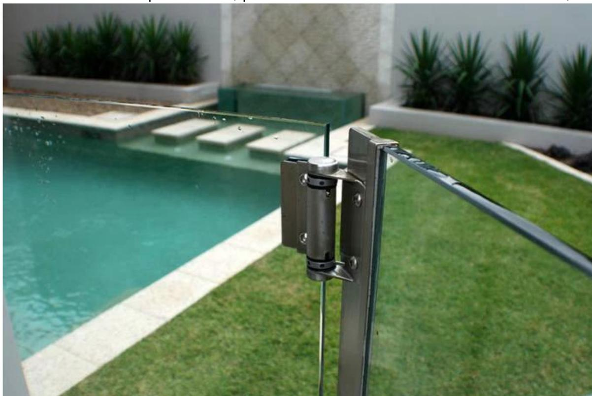
Verre charnière de porte peut être utilisée à la porte de la clôture de la piscine de verre, porte porte, il est la conception de fermeture automatique avec réglage de la tension.
