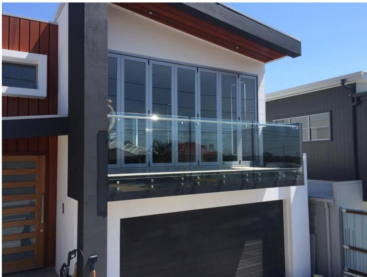
Colonne pour les affaire rampe d'escalier
