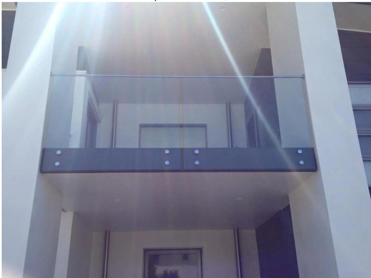
Main courante tube de fente est utilisé en haut de la clôture de verre, qui rendent votre balustrade en verre sans cadre semi-sans cadre plus stable et plus forte, et pour protéger la main.
