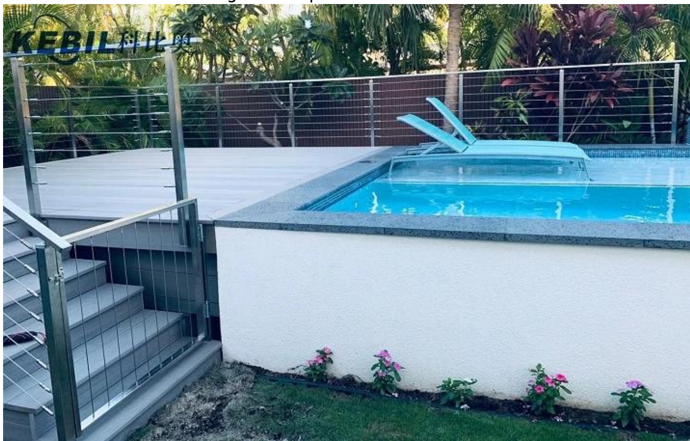
Conception de garde-corps en câble d'acier inoxydable pour la conception d'escalier extérieur ou de garde-corps de terrasse:
