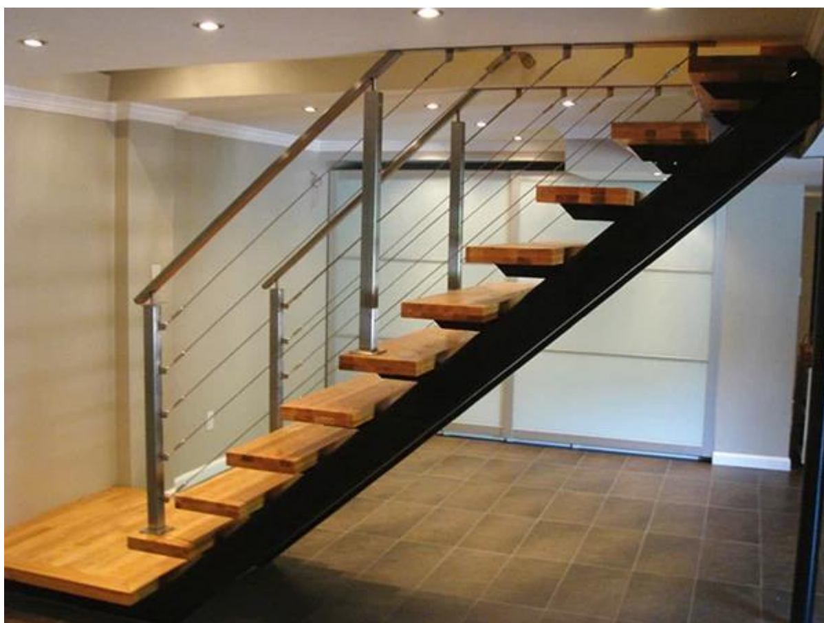
Mains courantes de balustrade de câble métallique de conception d'escalier intérieur
