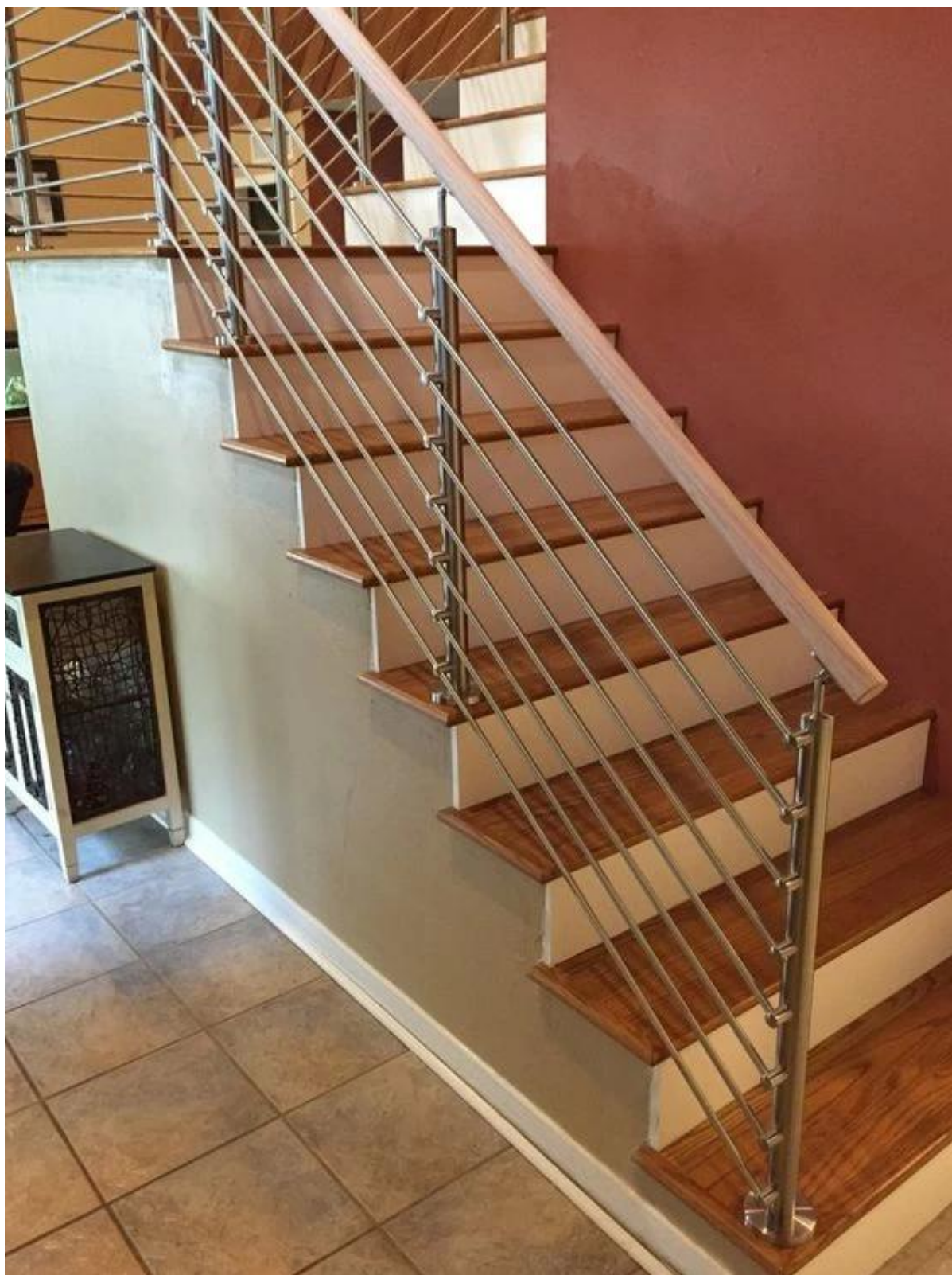
Photos du projet de garde-corps en acier inoxydable -
