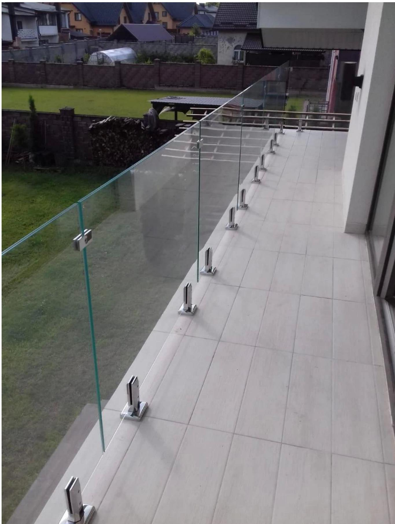
**Collier en verre à 90 degrés pour garde-corps sans cadre modèle PV-90:**
