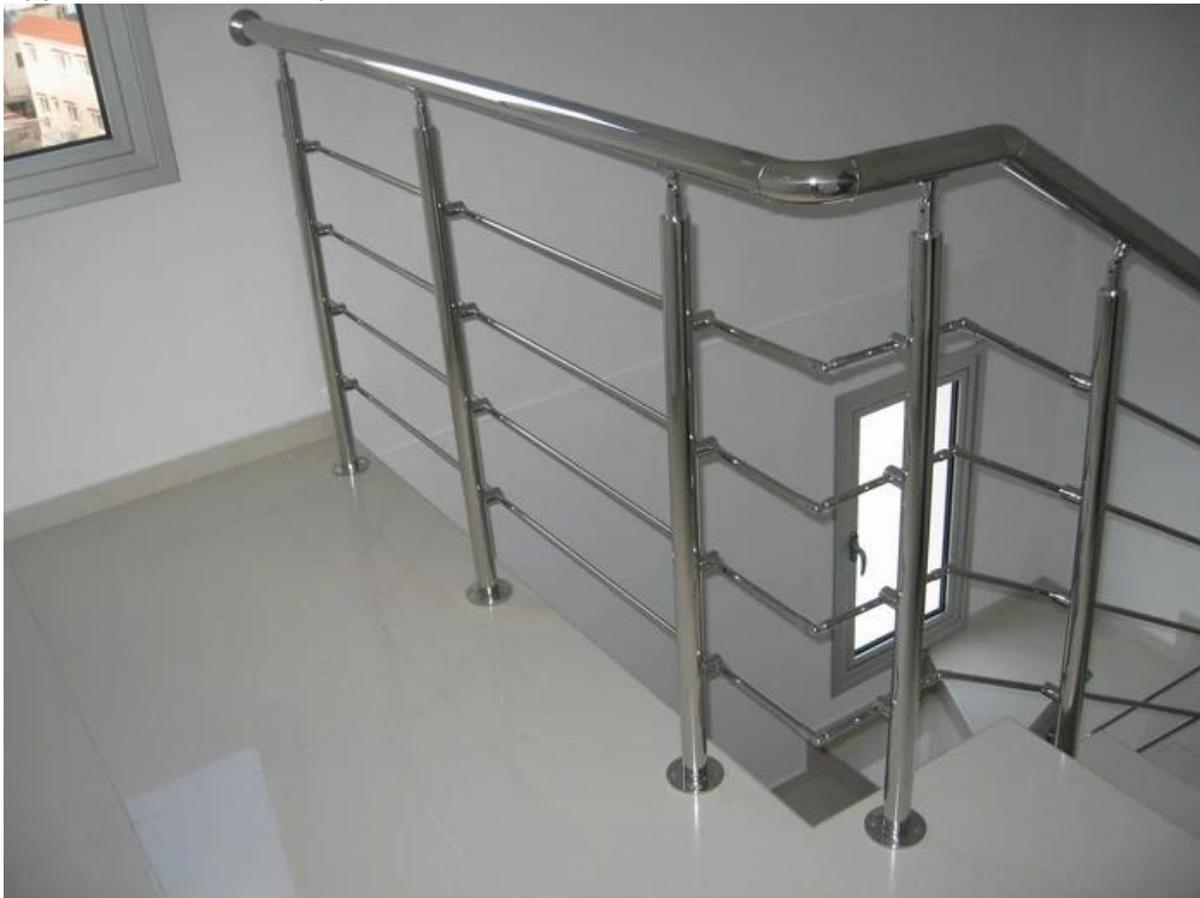
Croix conception de garde-corps de la barre pourrait être utilisée intérieure et extérieure, y compris balcon, terrasse, staircase. Il pourrait être conçu à la fois avec montage au sol et sur le côté de montage, dépend de votre exigence de projet.
