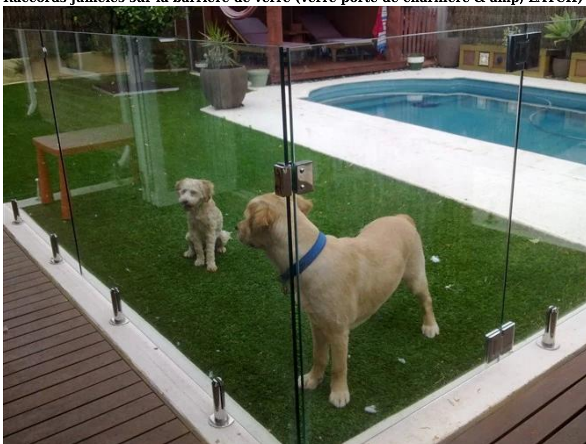
Raccords jumelés sur la barrière de verre (verre porte de charnière & LATCH)
