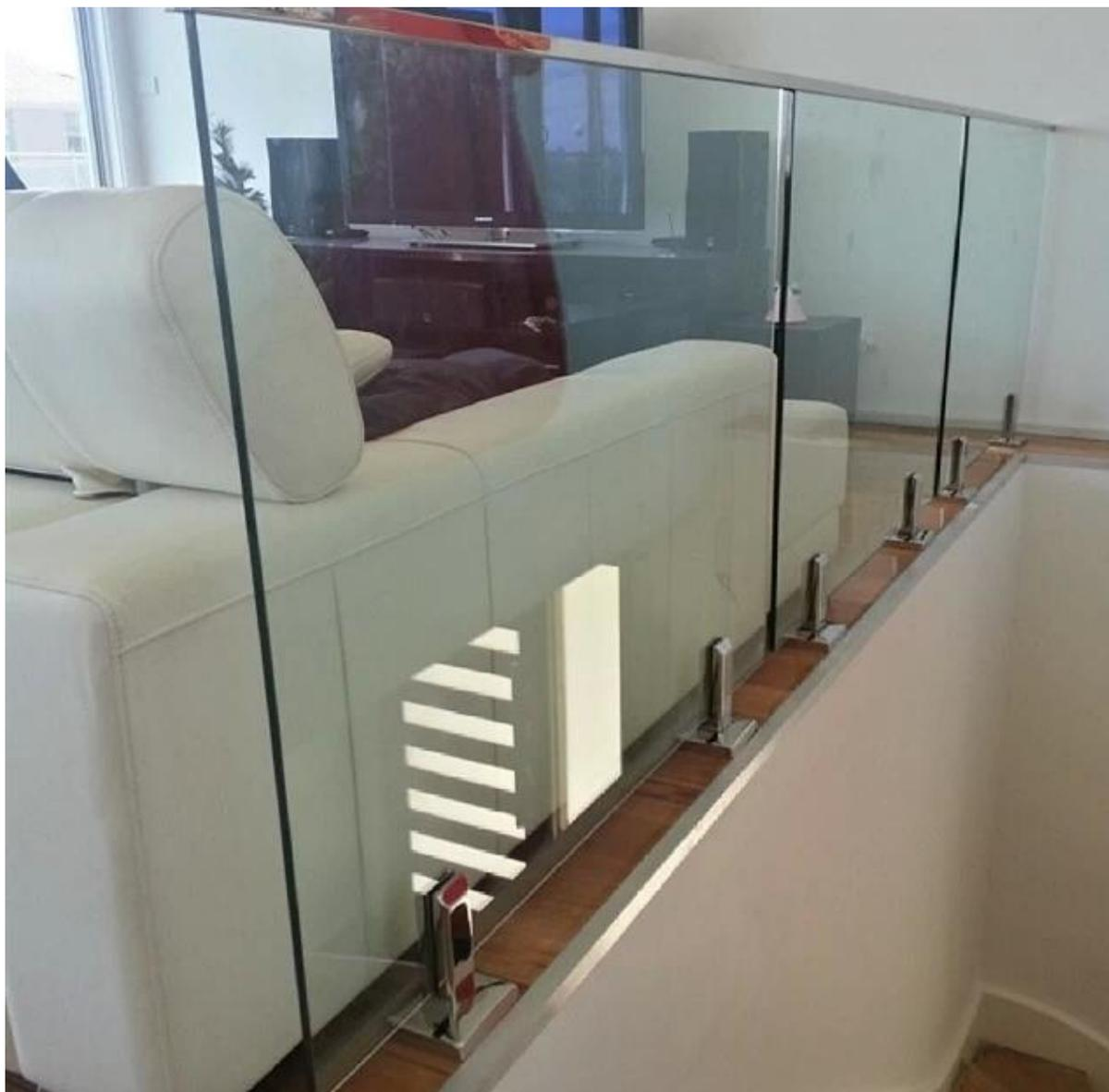
4. Chine fournisseur carrés inoxydables raccords de main courante en acier pour le paquet de garde-corps en verre 8-13.52mm:
