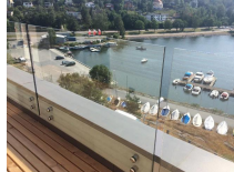
supports d'écartement en verre installé sur un balcon escalier
