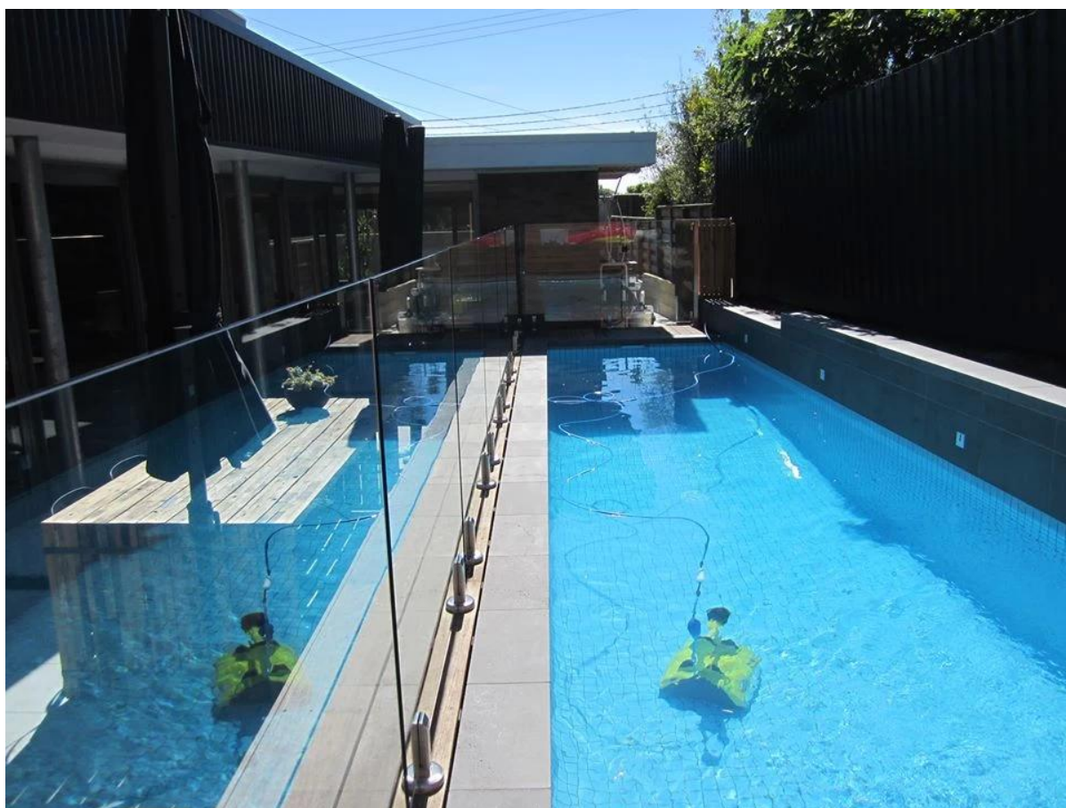
• Photos d'installation d'une clôture en verre sans cadre,
