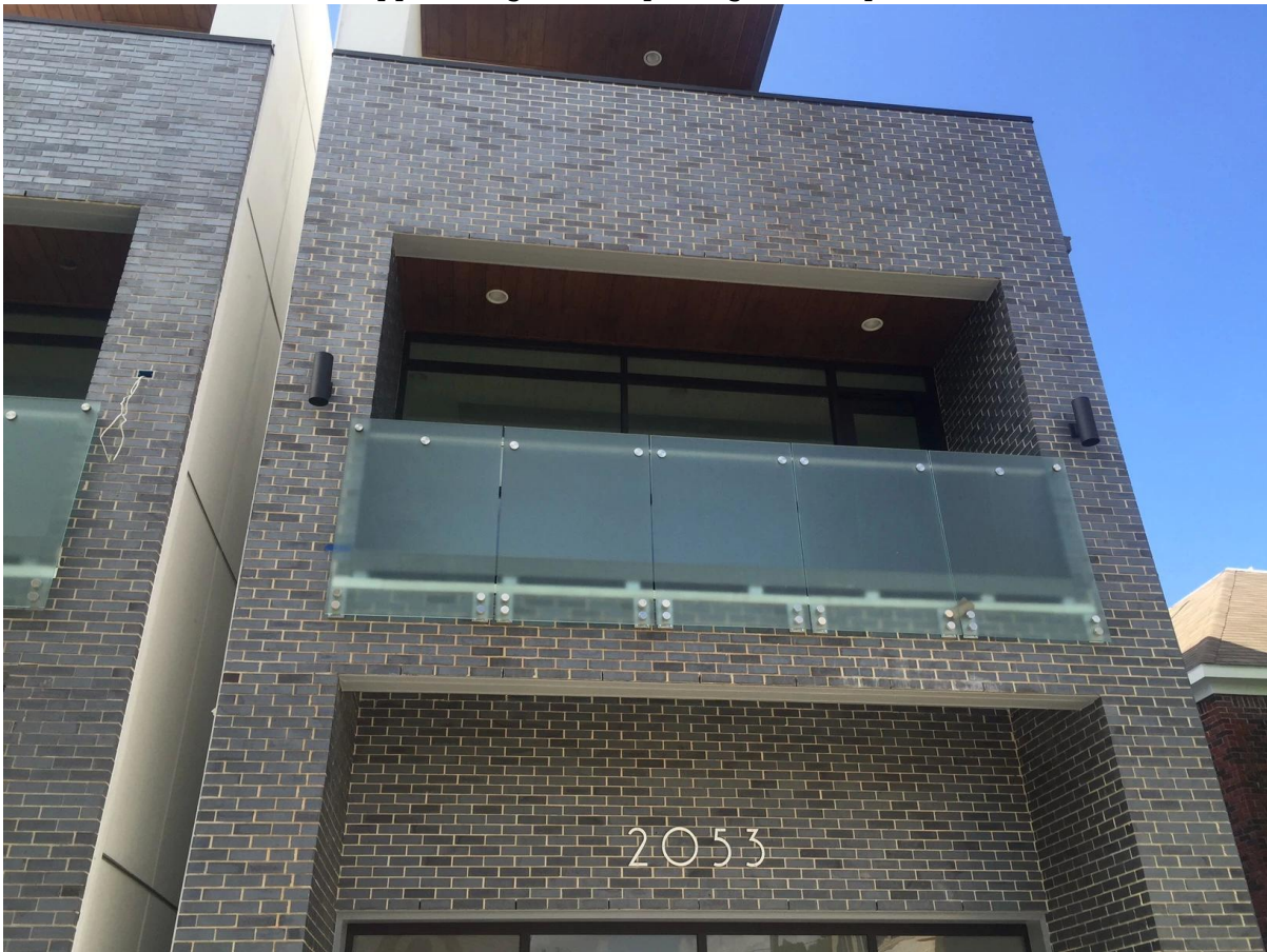
Photos d'installation du support de garde-corps de garde-corps en verre
