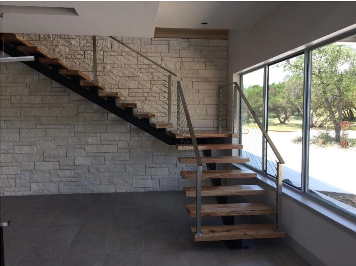
inoxydable conception câble de garde-corps en acier pour escalier intérieur
