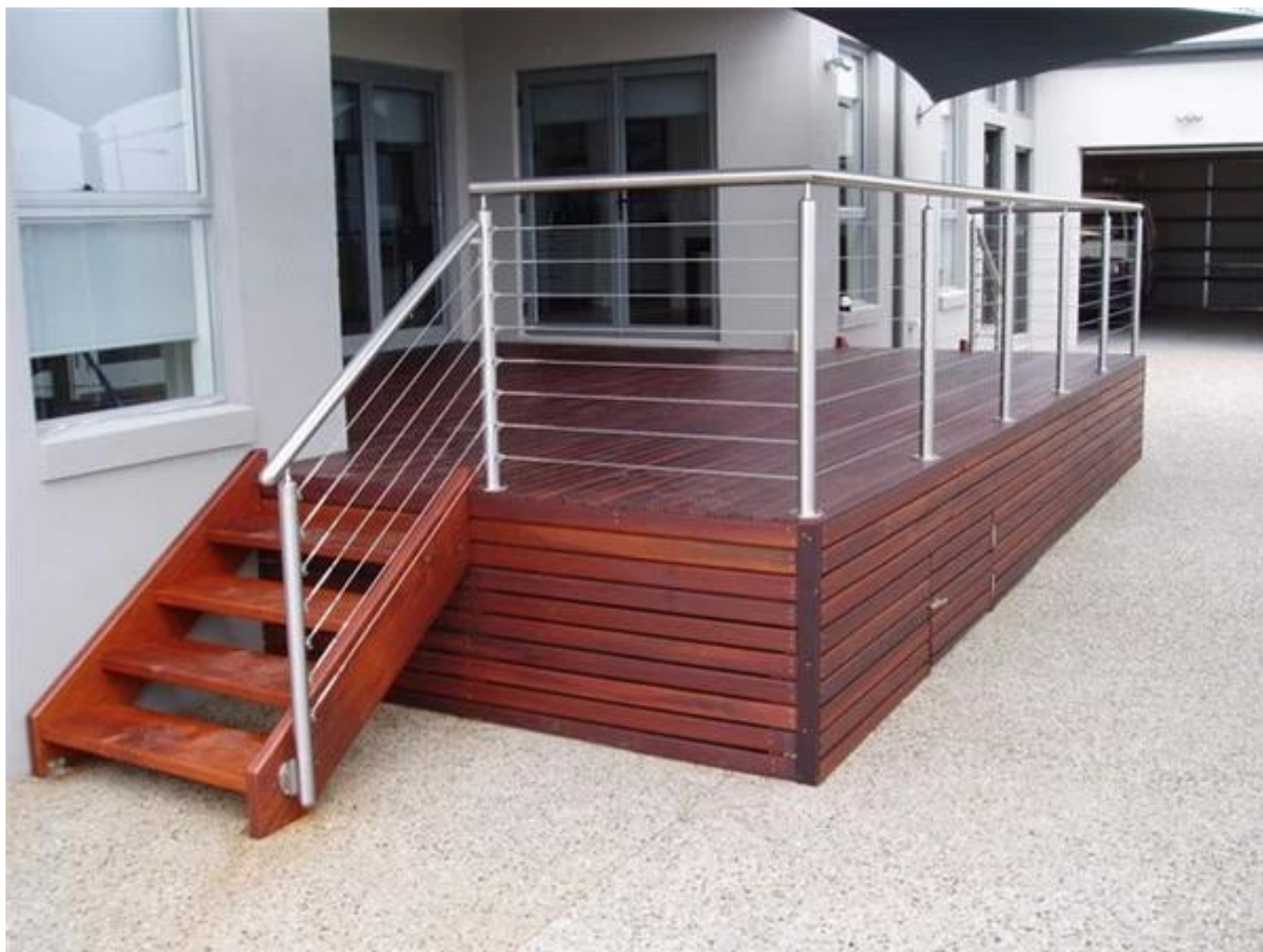
fil de câble
