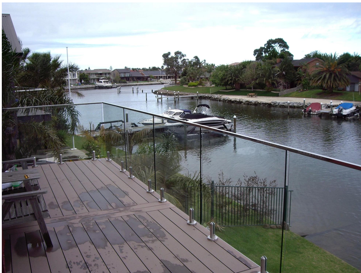
3). top rails en acier inoxydable verre intérieur garde-corps:
