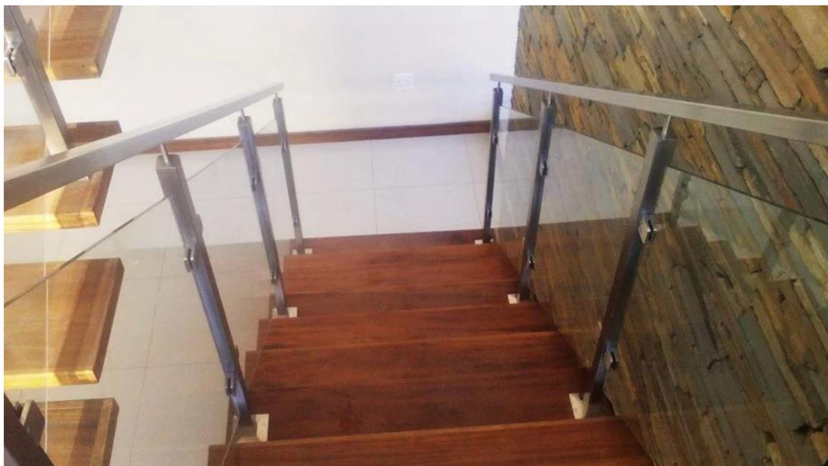
5. Ronde Forme poteau en acier inoxydable pour pont balcon escalier verre rambarde projet:
