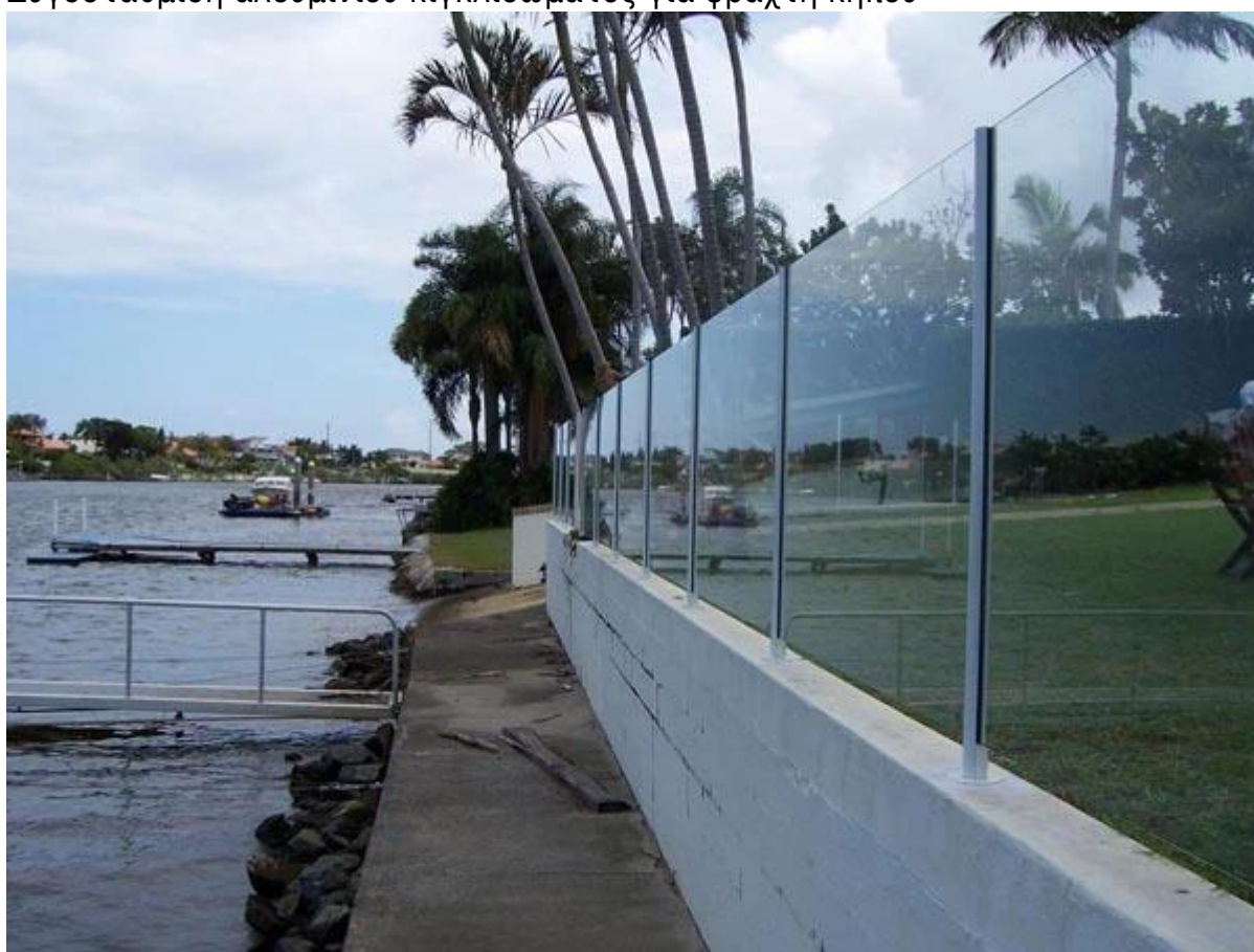
Γκρι κονίαμα αλουμινίου κιγκλιδώματος αλουμινίου για φράχτη πισίνας.
