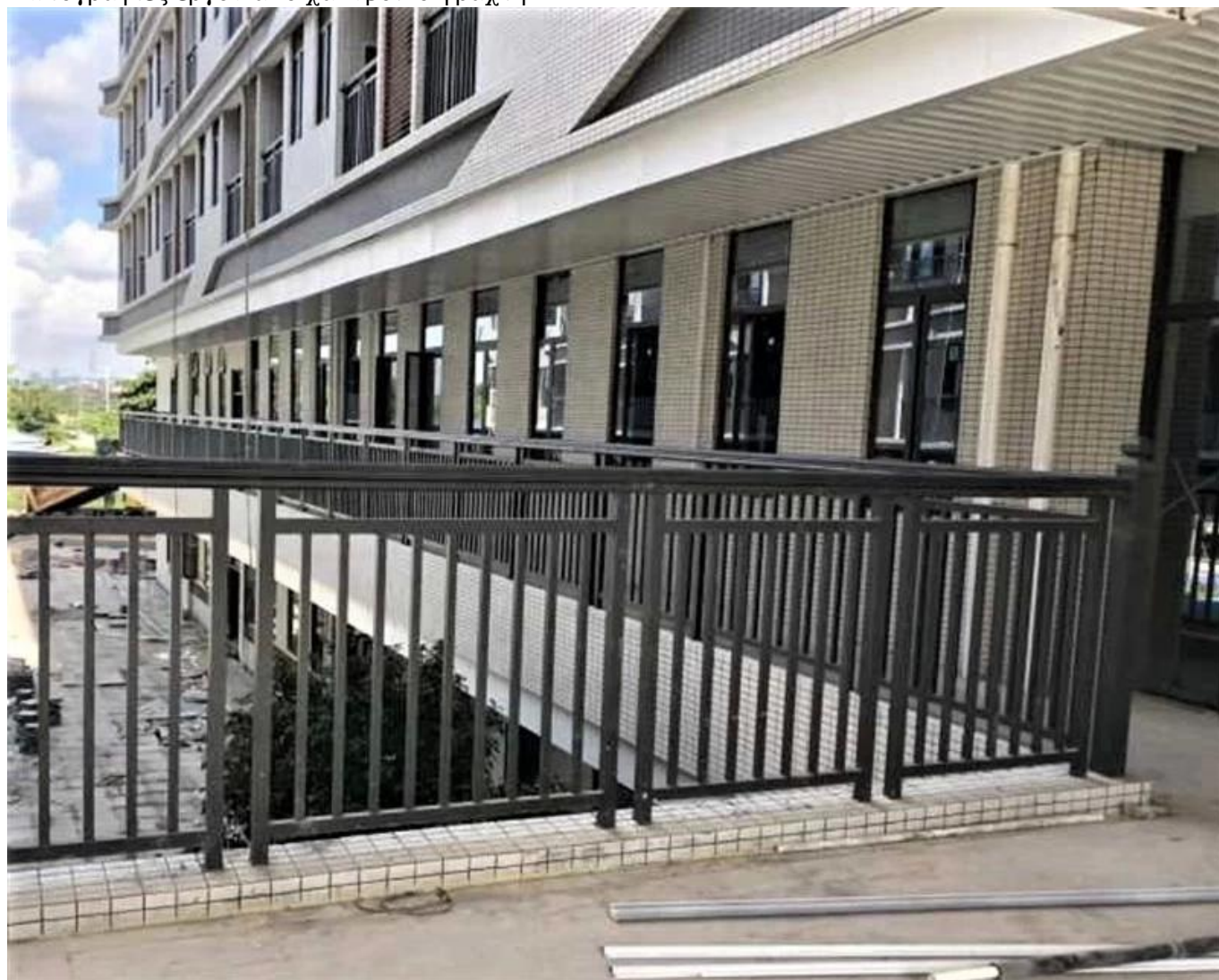
Φωτογραφίες έργου από χαλύβδινο φράχτη-
