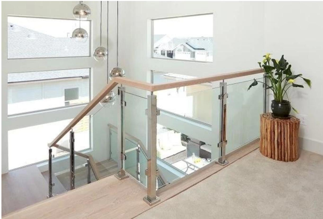
Ο σφιγκτήρας γυάλινο κιγκλίδωμα που χρησιμοποιείται συνήθως με ανάρμοστη ανάρτηση για να κρατήσει γυάλινα πάνελ,
