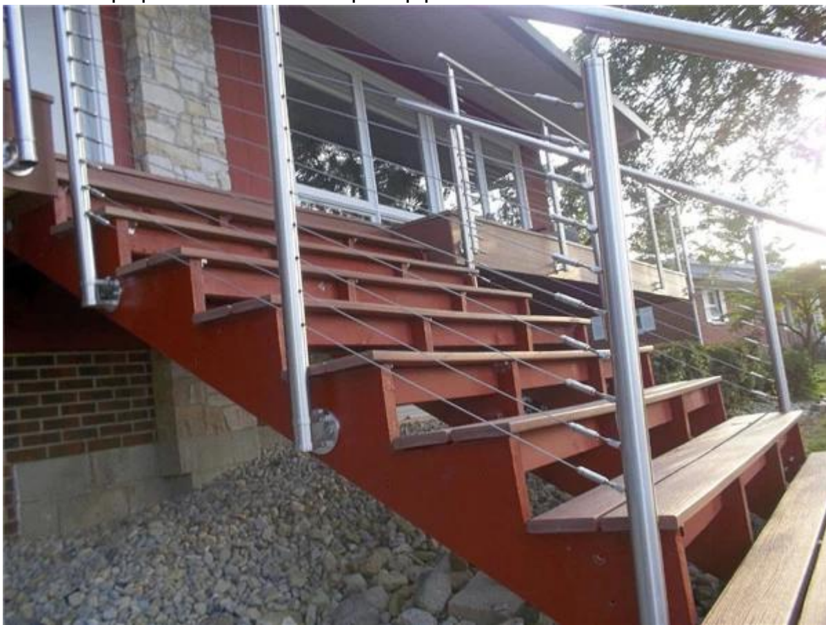
Τοποθέτηση καλωδίων T803 για έργα σκαλών
