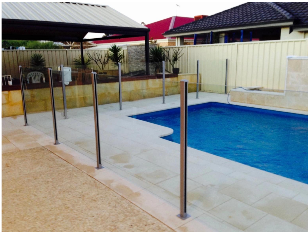
(2) στρογγυλή ημι γυαλί περίφραξη αργιλίου post : διάμετρος 50 mm x 3 mm
