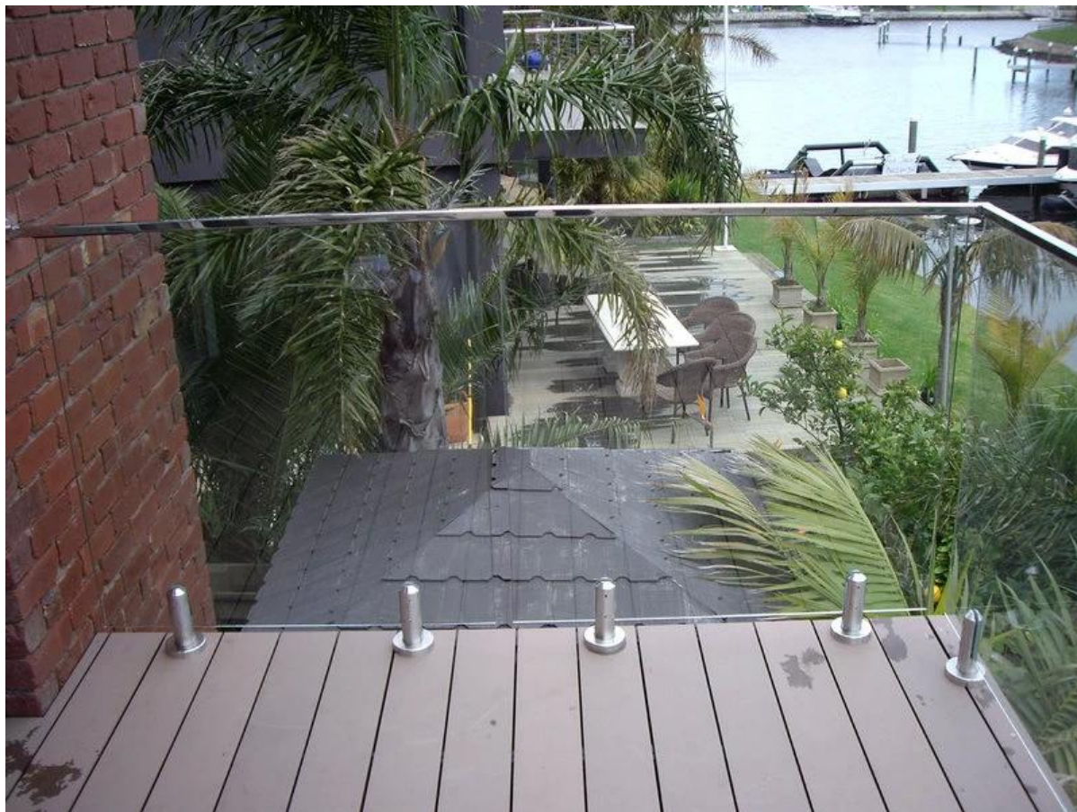
Εξωτερική κατάστρωμα κιγκλίδωμα γυαλιού
