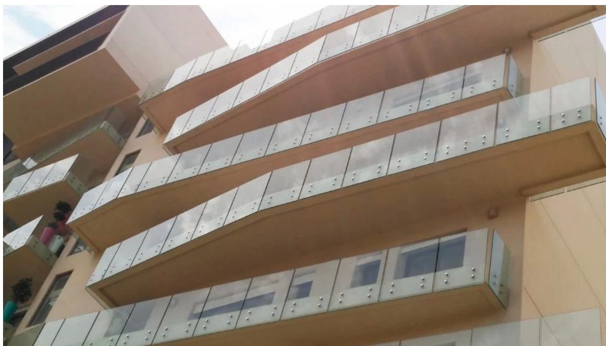
Φωτογραφίες έργου από ανοξείδωτο χάλυβα 316 γυάλινες κιγκλιδώματα standoffs-
