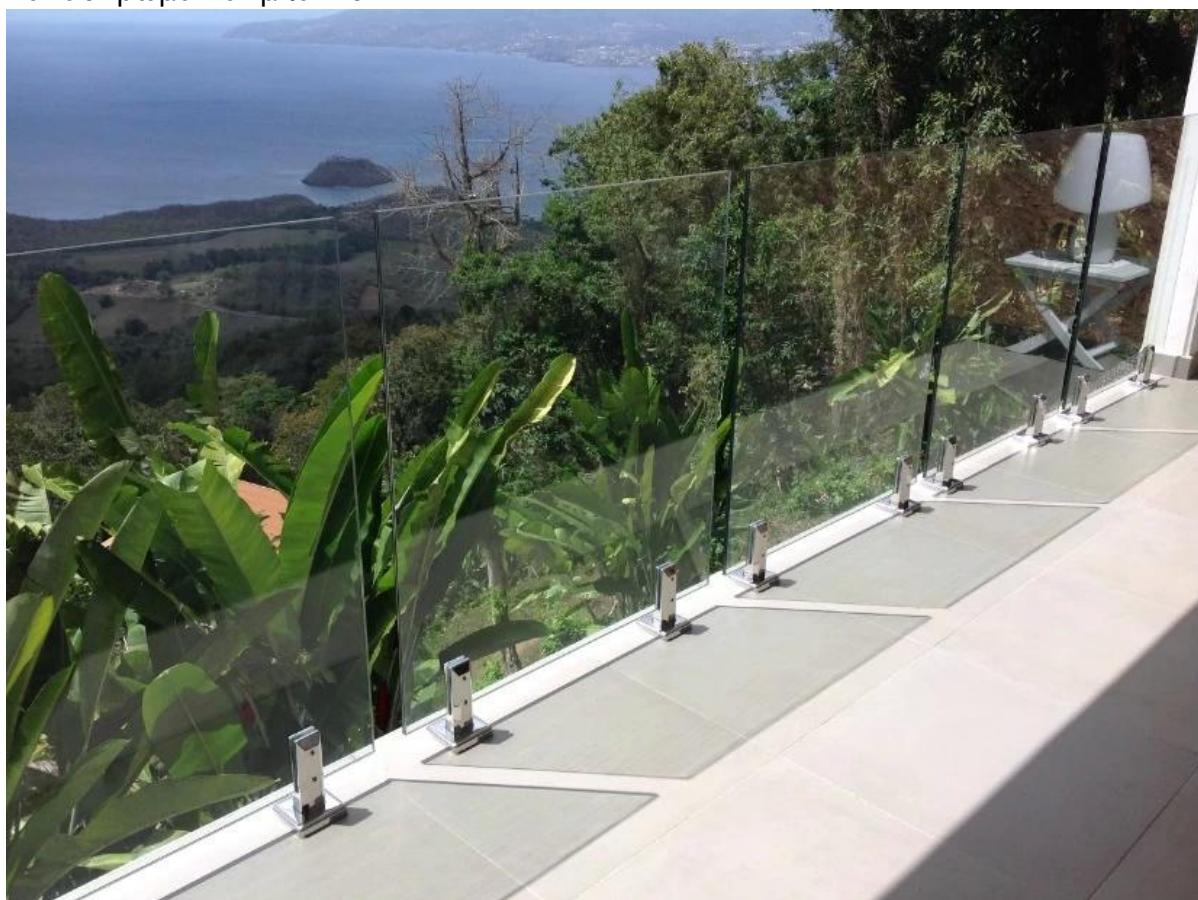
Τάπα χρησιμοποιείται ευρέως ως γυαλί φράκτη πίνακα υποστήριξης στο κατώτατο σημείο, εγκατεστημένο στο ξύλο, σκυρόδεμα, χάλυβας πάτωμα στο μπαλκόνι, κατάστρωμα, φράκτη
