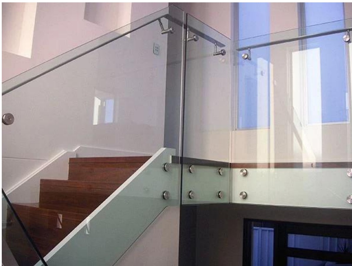
3) Ανοξείδωτο χάλυβα 316 αντιπαράθεση υλικού βραχίονες στήριξης γυαλί συνδετήρα εσωτερική διάδρομο γυαλί σχεδιασμό κιγκλίδωμα
