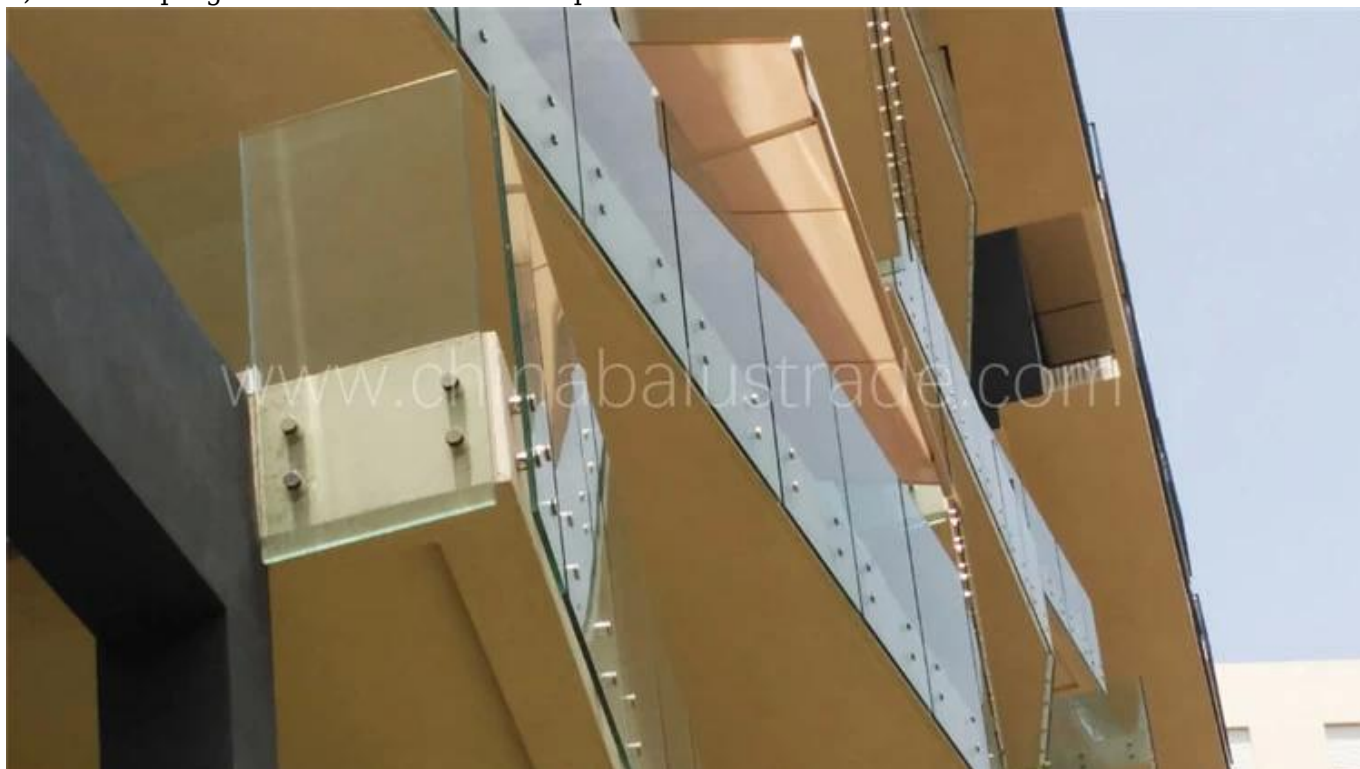
4).Foto del progetto di sistemi di distacco per balaustre in vetro senza telaio-
