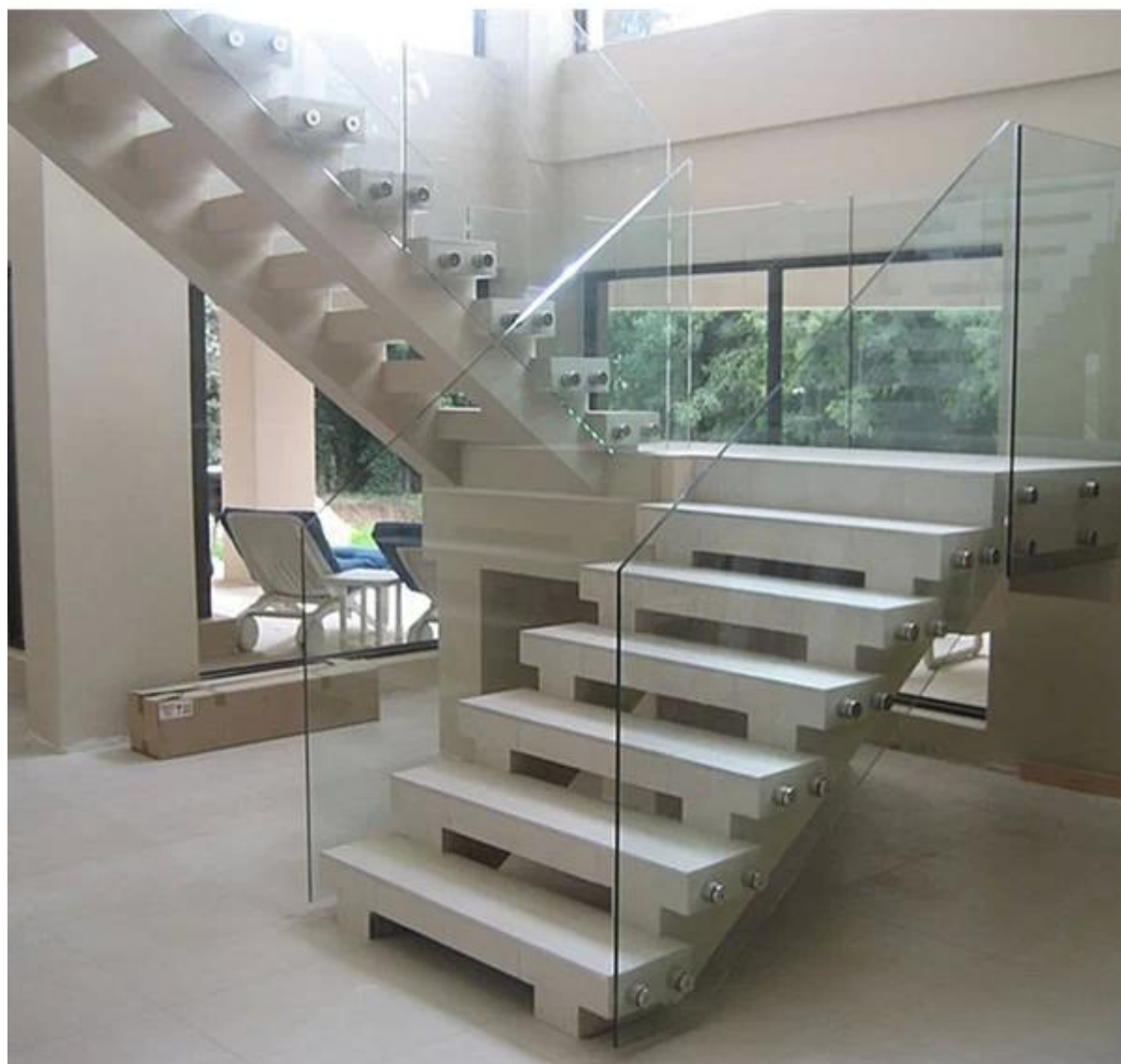
Standoff di vetro in acciaio inossidabile per balaustra in vetro senza telaio
