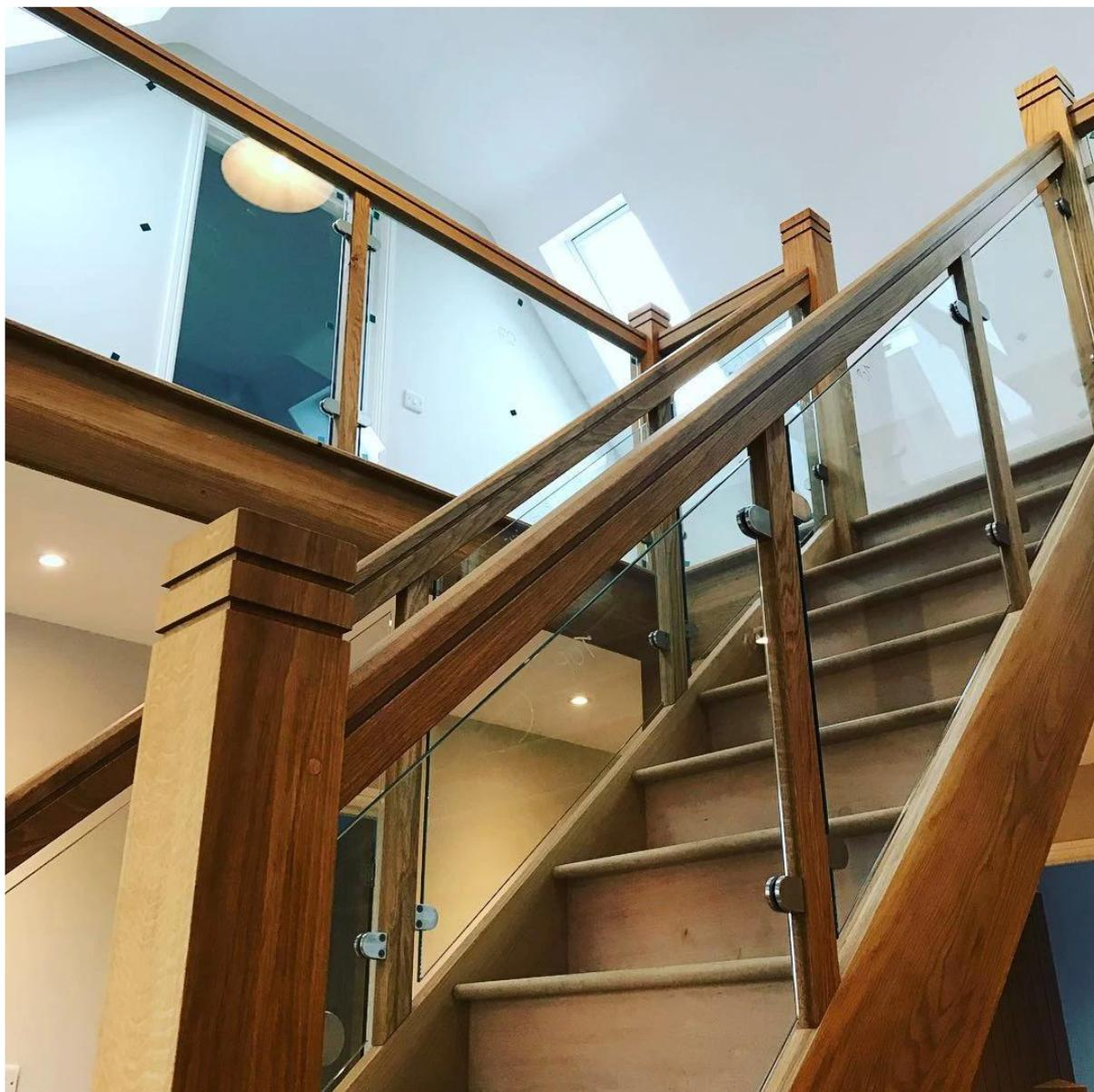
il morsetto usato solitamente con il posto dell'acciaio inossidabile per tenere i pannelli di vetro, per la ringhiera del balcone, la ringhiera del terrazzo, la scala. Adatto sia per interni che per esterni.
