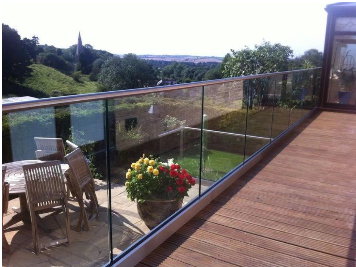
Alluminio U canale + disegno di vetro temperato da 10-12mm
