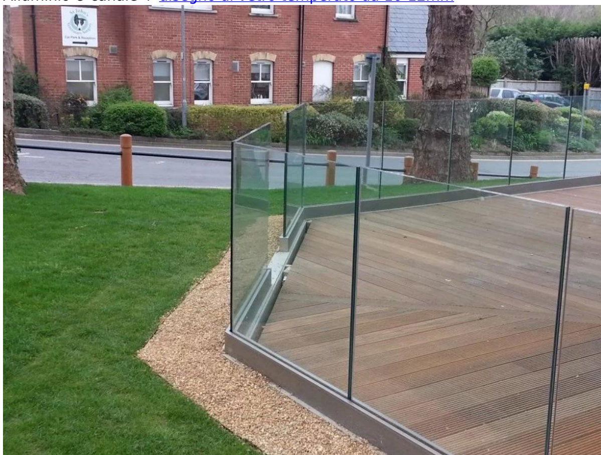
Alluminio U canale + disegno di vetro temperato da 10-12mm
