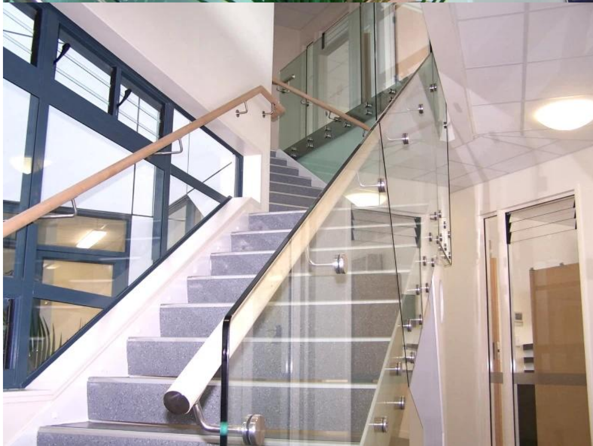
situazione di stallo + vetro temperato
