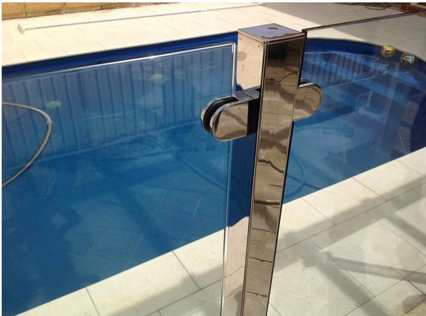
Il morsetto di ringhiera in vetro solitamente utilizzato con post in acciaio inox per contenere pannelli di vetro,
