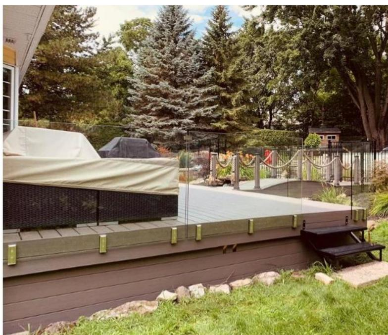
Spigot in vetro per piastra base per montaggio a pavimento e perno in vetro per carotaggio
