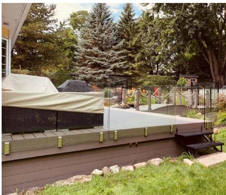
Attacco per vetro base di montaggio a pavimento e attacco per vetro per carotaggio
