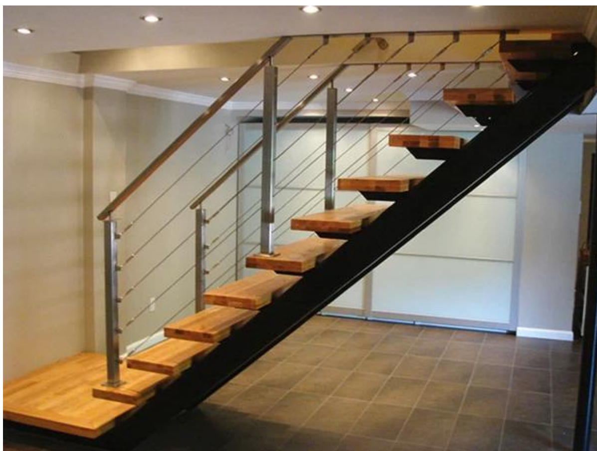
Corrimano per balaustre in fune metallica per scale interne
