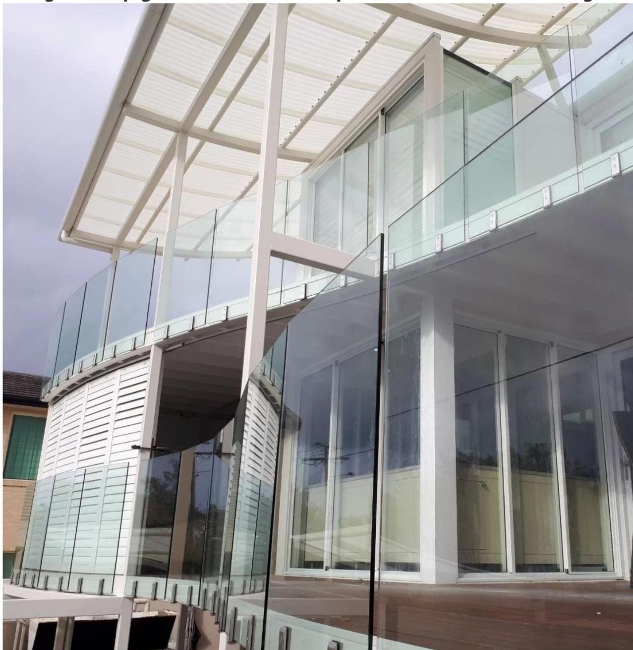
**Montato a pavimento Balastra di vetro di alluminio del canale di U,
