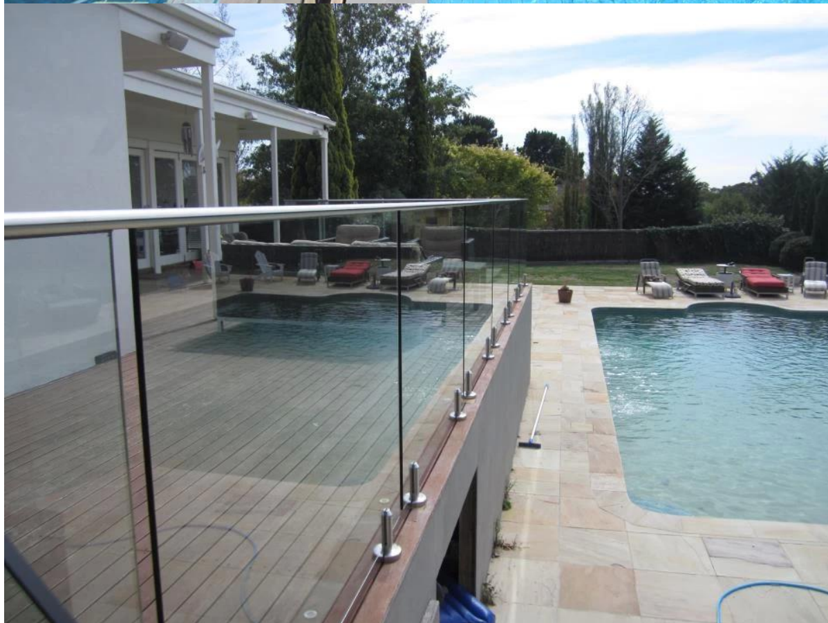
Piattaforma esterna / balcone
