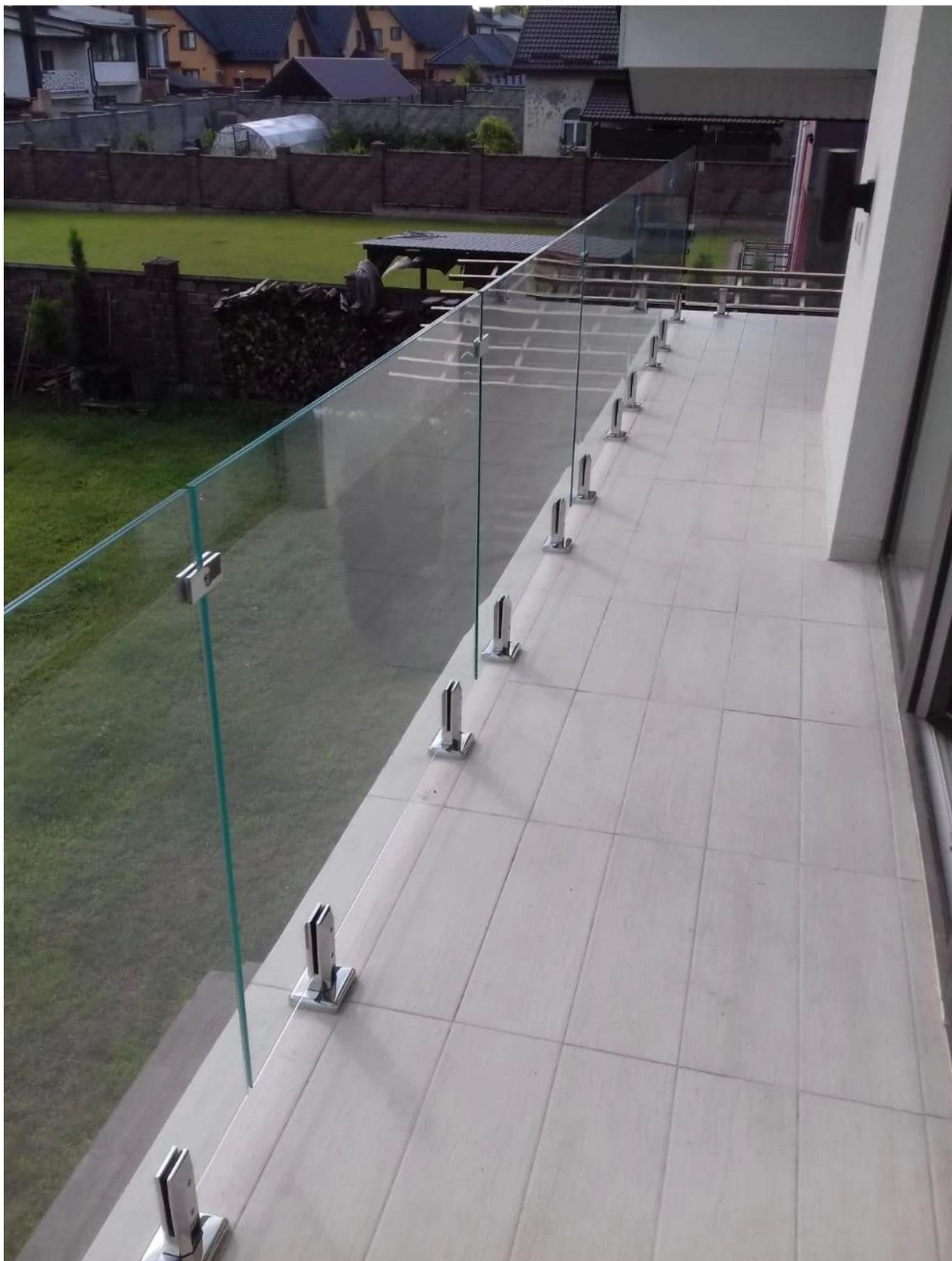
**Morsetto per vetro a 90 gradi per ringhiera senza telaio Modello PV-90:**
