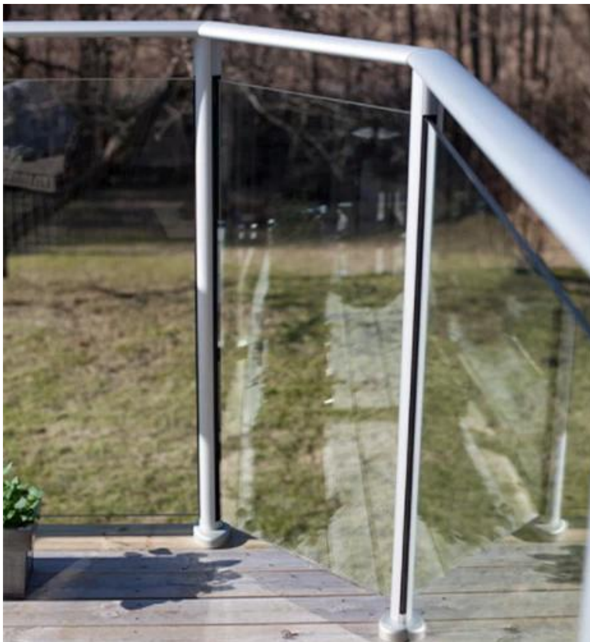
Pannelli di recinzione di vetro per corrimano per scala esterna:
