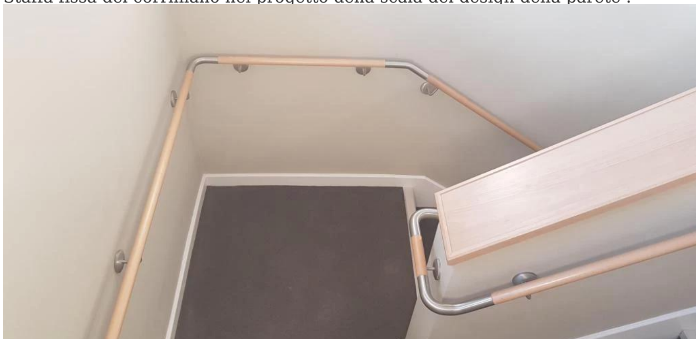
Staffa fissa del corrimano nel progetto della scala del design della parete :
