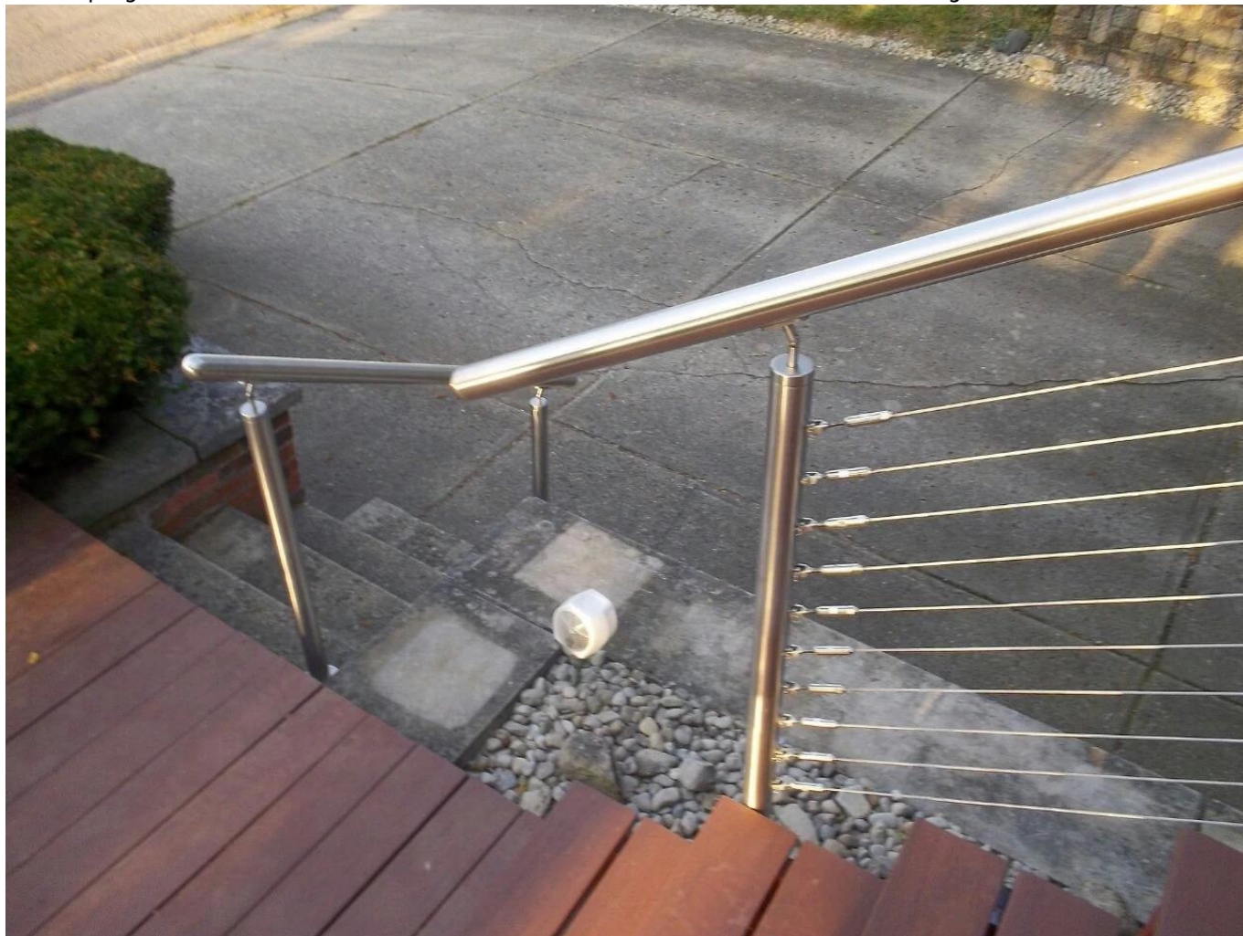
Foto di progetto di balaustre in fune metallica con tenditore filettato a fune T803 Swageless-
