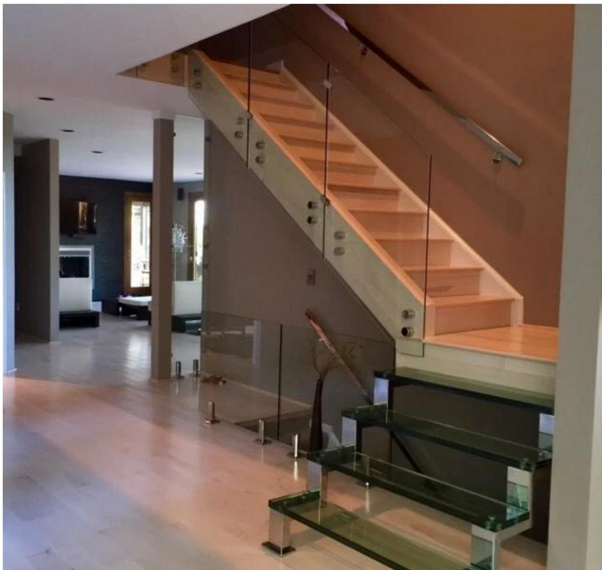
Questo morsetto di vetro è ampiamente usato in balaustra di vetro senza cornice particolare per la scala, ponte, balcone e così via, non solo commerciale, ma anche progetto domestico.
