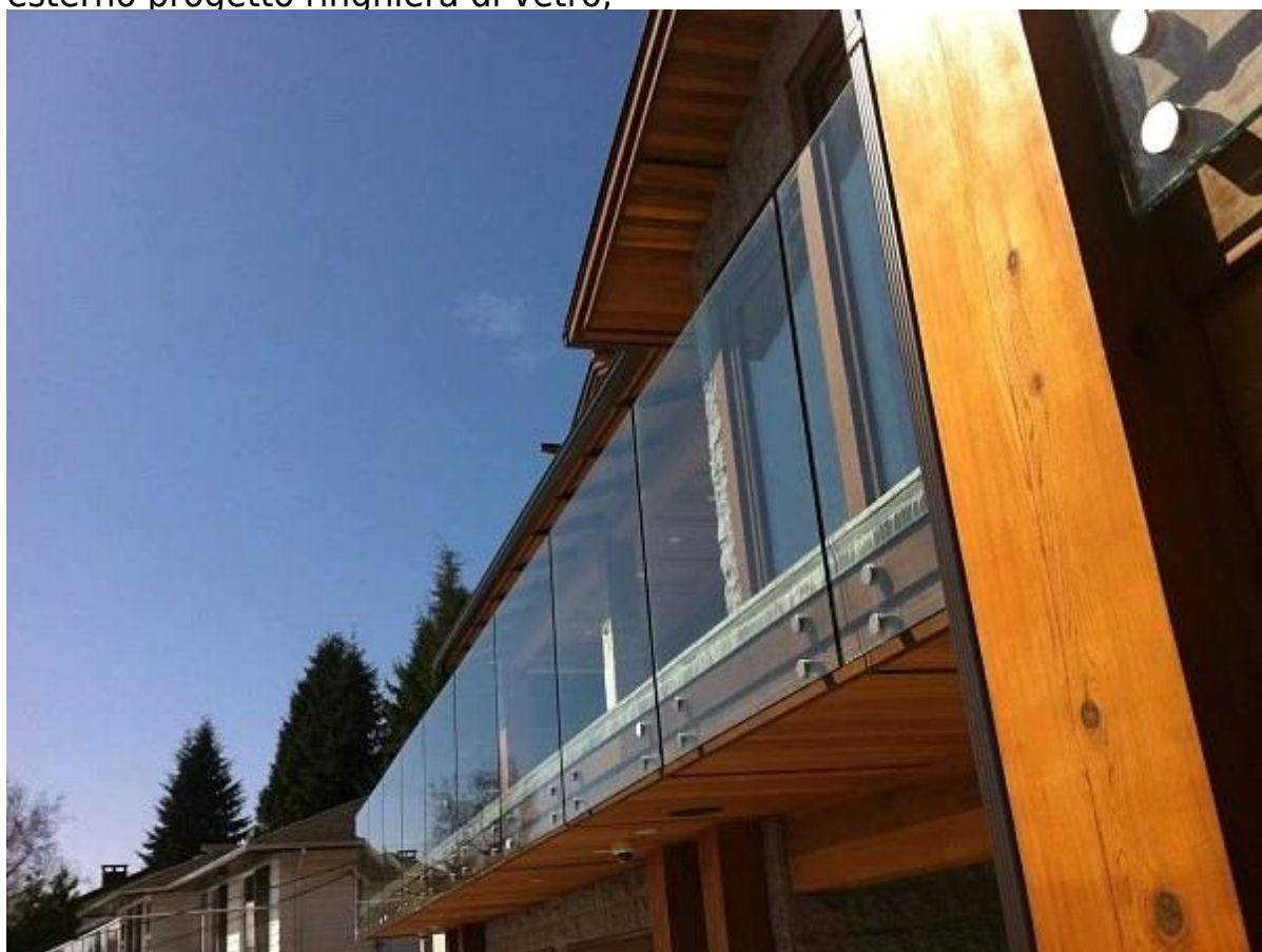
piattaforma esterna del progetto ringhiera di vetro,
