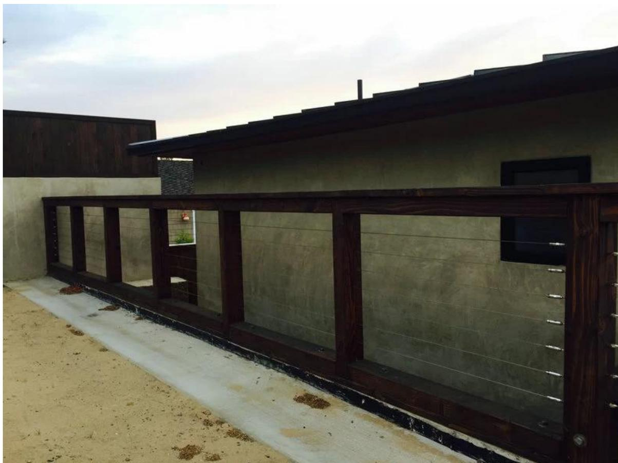
**Cavo Ringhiera in acciaio inox tensinoer sono ampiamente usati in balcone, ponte, scale e terrazza, è molto buona soluzione se non vi piace il design ringhiera di vetro.**
